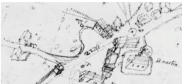
G.F.Meyer: St.Martin Titterten, 1680. Die Kirche ist noch vom Friedhof umgeben, der Dachreiter befindet sich auf der Ostseite
