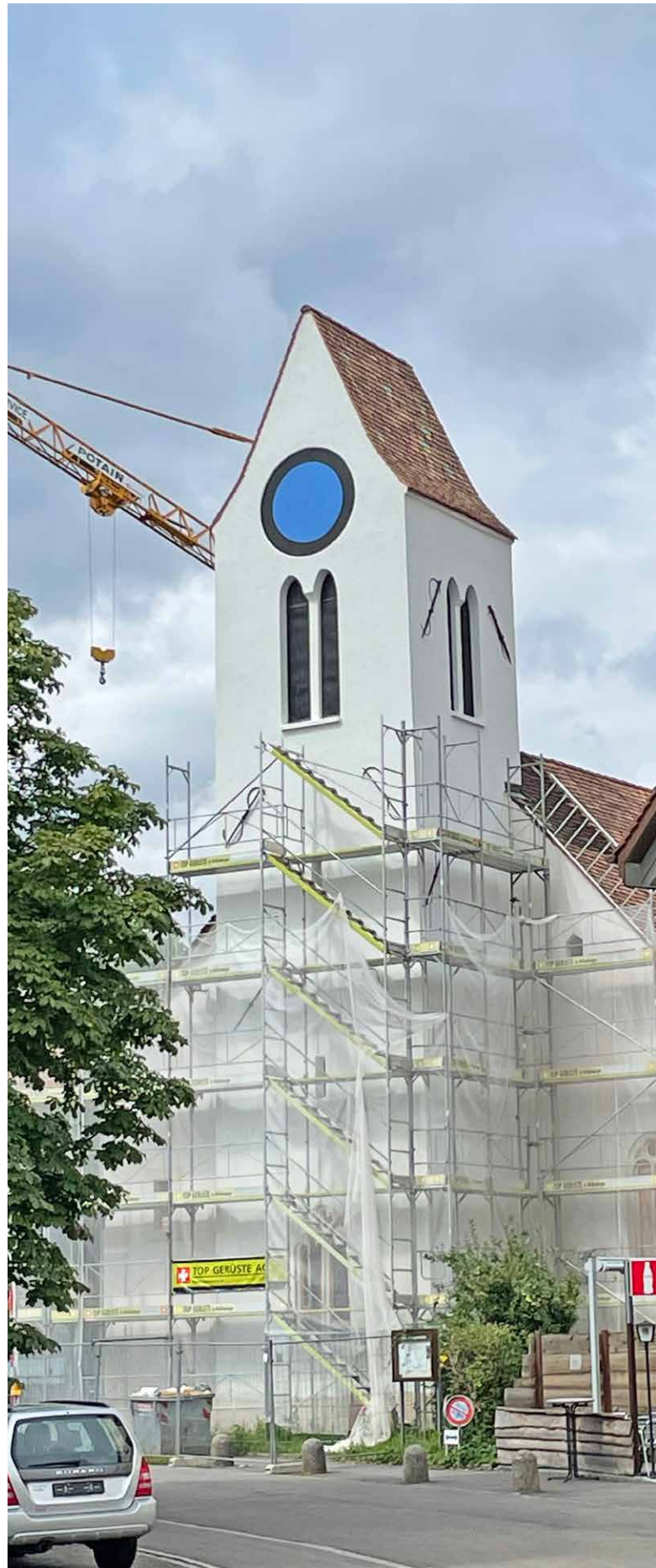
Aussenrenovation der reformierten Kirche Frenkendorf.
