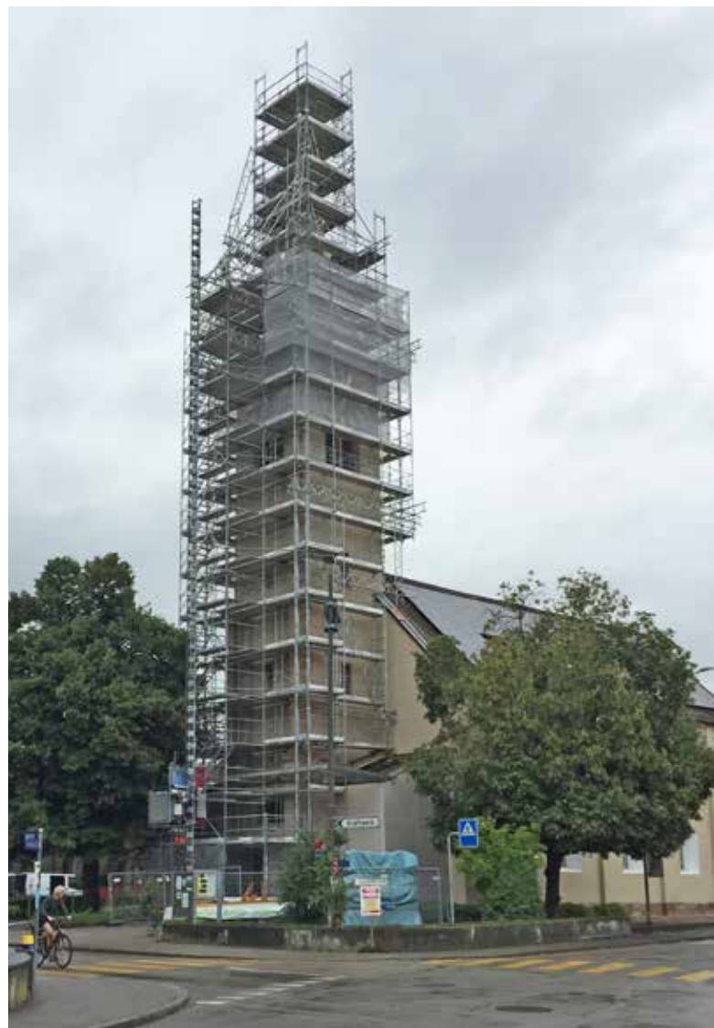
Das Kirchturmdach der Kirche Birsfelden wird renoviert.
